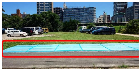
<コンパネによる養生例>
